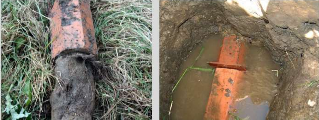
Obr. 4 / Vlevo: Účinek kombinace zarůstání průtočného profilu kořeny bylin a zanášení splaveninami z drenážní vody (foto: M. Čmelík) Vpravo: Příklad instalace záslepky (případně clony) na drénu, kdy je PVC záslepka vložena do stávajícího drénu z pálené hlíny, průměru 0,13 m. (foto: M. Soukup)
