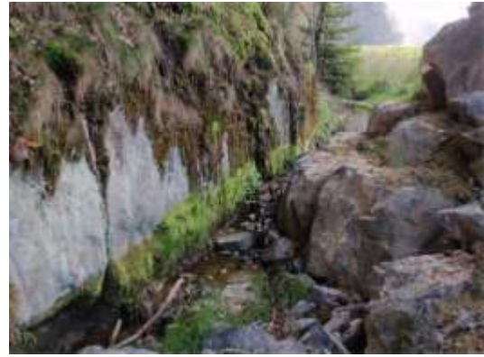
Obr. Ukázka navrženého a realizovaného průtokového hrazení na PB přítoku Bynoveckého potoka.
