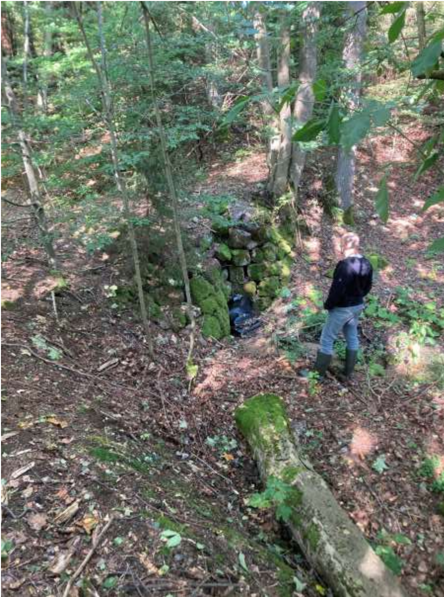
Obr. 37: Zbytky hráze retenční nádrže na Huťském potoce
