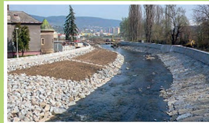
Povodňová úprava koryta Litavky v Králově Dvoře (Just T., https://strednicechy.ochranaprirody.cz )
