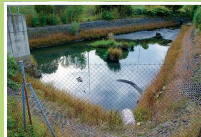
Dešťová retenční nádrž u nákupního centra v Ivanovicích ( www.kafelenka.cz )
